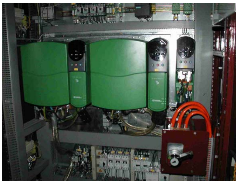
Fig. 6: "KAROLA" – Torre di alimentazione nel reparto verniciatura con quadro di azionamento
