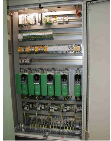
Fig. 5: Convertitore a portale per il collegamento delle celle di saldatura robotizzate nella produzione della scocca con un dettaglio del quadro elettrico
